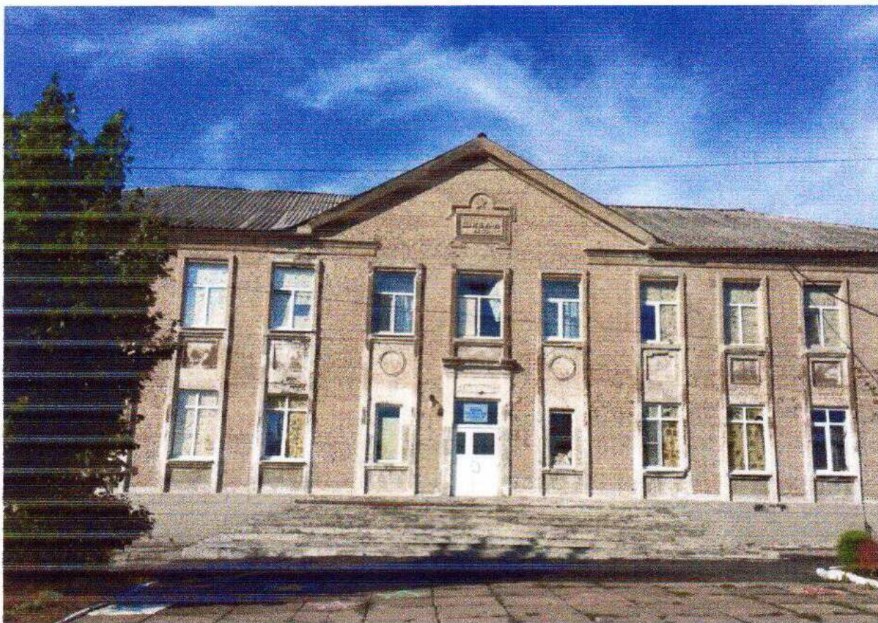
(Школа № 98. Фасад. Сентябрь 2014 г.)
