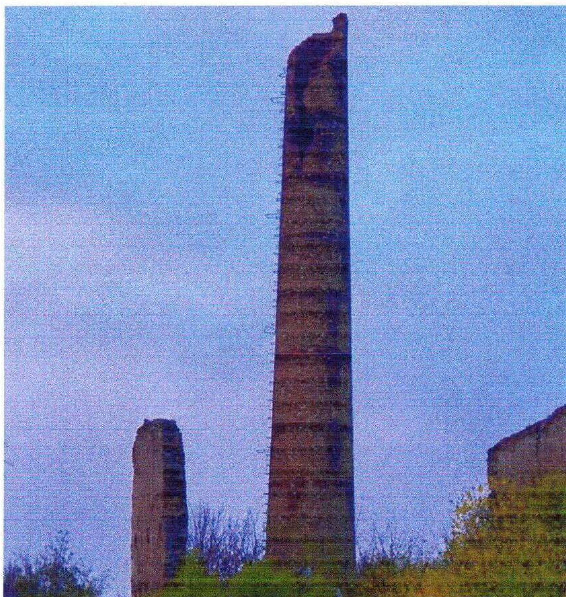
(Руины шахты «Нижнекрынская»)
